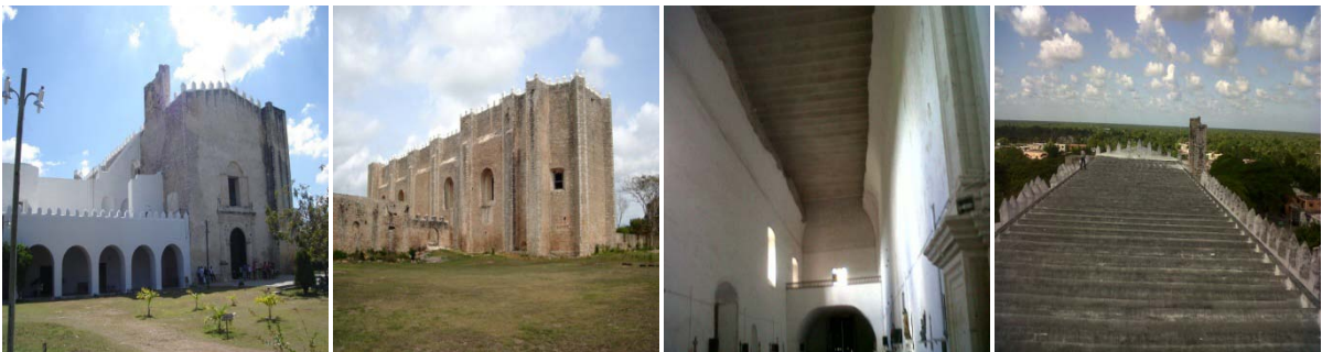
Figura 1. Fachada delantera y trasera del ex-convento y Templo de Santa Clara en Dzidzantún, Yucatán. Vista interior y exterior de la cubierta de la nave longitudinal.
